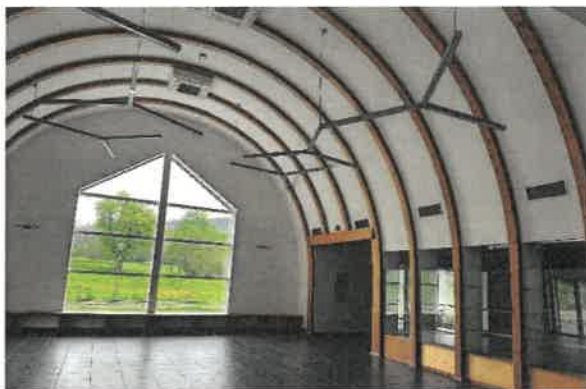
Zdjęcie: 2 Hala Morgi po remoncie
